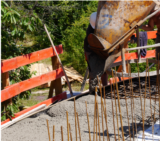
Recyclingbeton wird auf dem Dach der entstehenden Umweltstation ausgebracht
