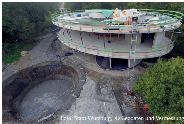
Aushub der Zisterne für den Eisspeicher unter dem Umweltstations-Parkplatz
