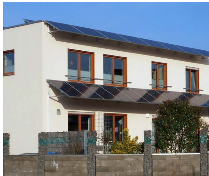
Verschattung durch Solar-Module
