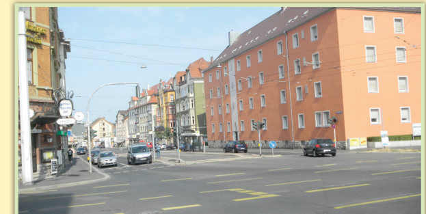
7 Gefahrenstelle Kreuzung Frankfurter Str./Wörthstr.: hohes Verkehrsaufkommen durch Fernverkehr, zu Stoßzeiten überfüllte Straßenbahnhaltestelle (Einstieg von Schülern, die von außerhalb mit Bus kommen).
