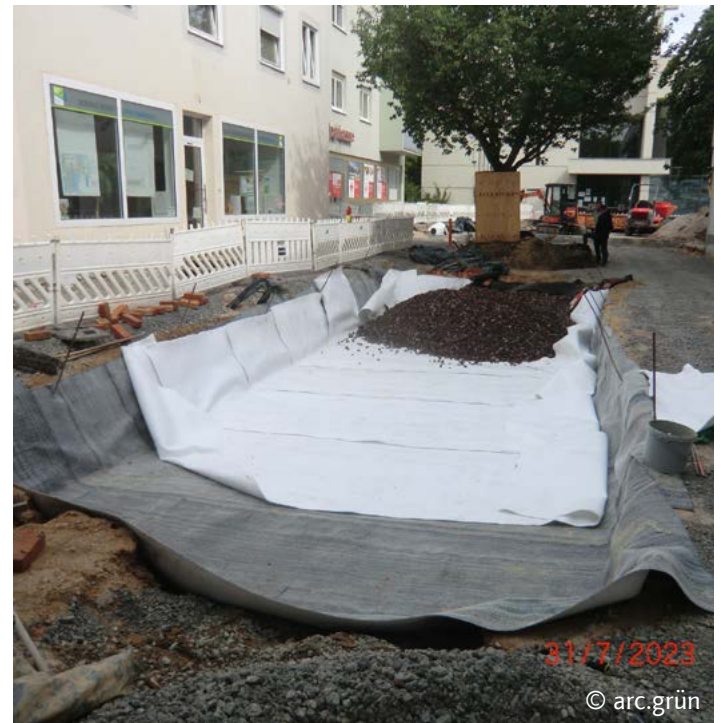
Speicheraushub mit Abdichtung
