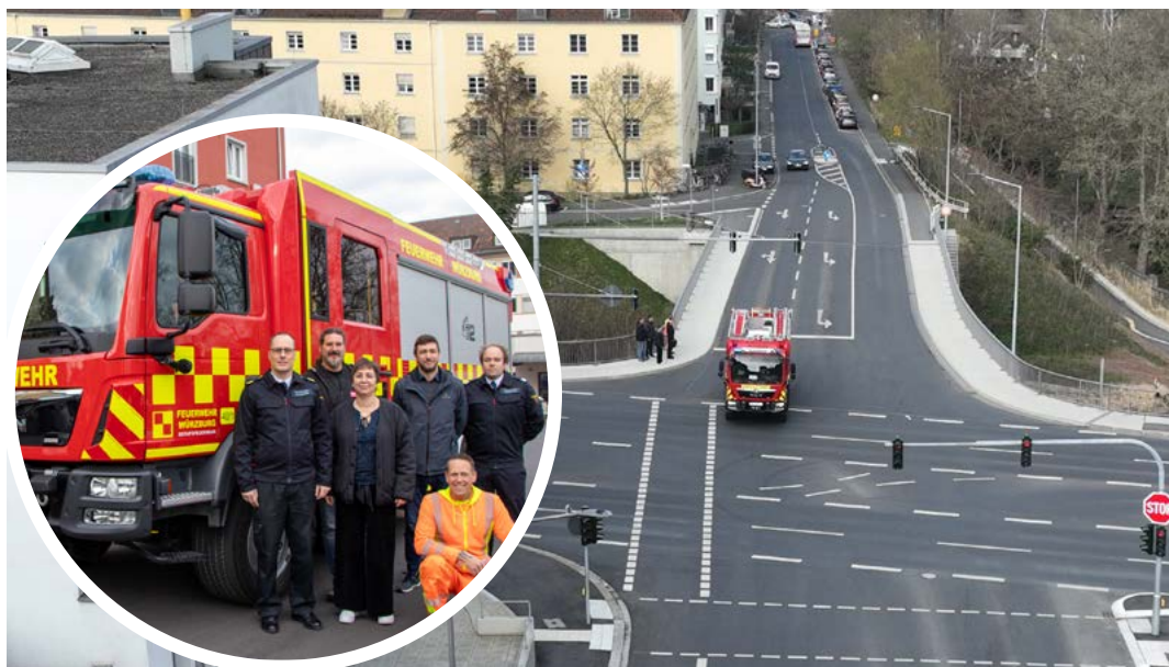
Zusammenarbeit Feuerwehr, FB Tiefbau und Verkehrswesen, WVV, Firma Yunex
