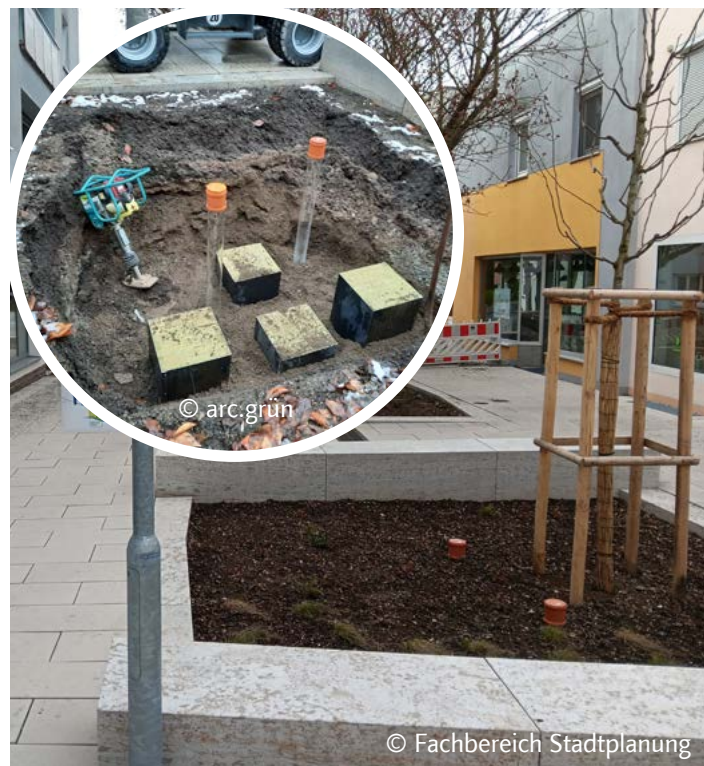
Pflanzgrube mit Dochte und Beobachtungsrohre
