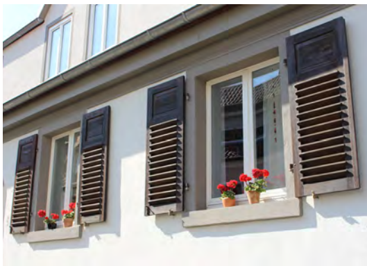
Ortsbildprägende Fensterformate mit Fensterläden
