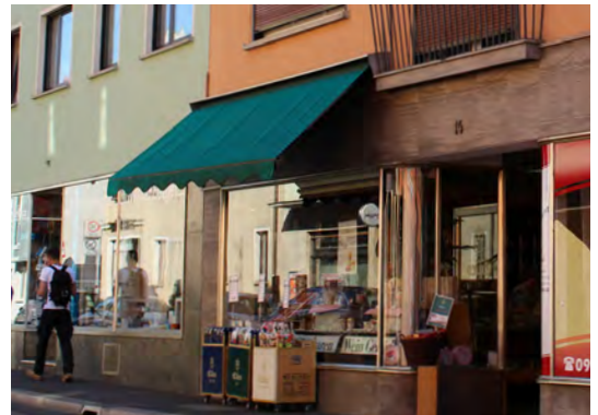
Markise als zurückhaltendes Element der Fassade
