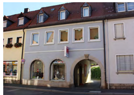
Lochfassade mit Torbogen
