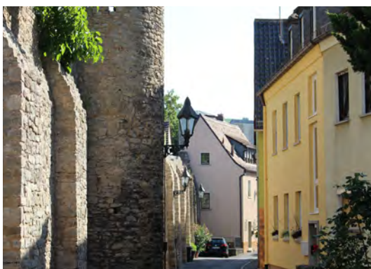
Sichtachse entlang der Straße An der Stadtmauer
