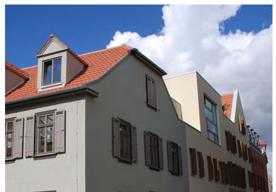
Krüppelwalmdach und Spitzgaube in saniertem Altbau
