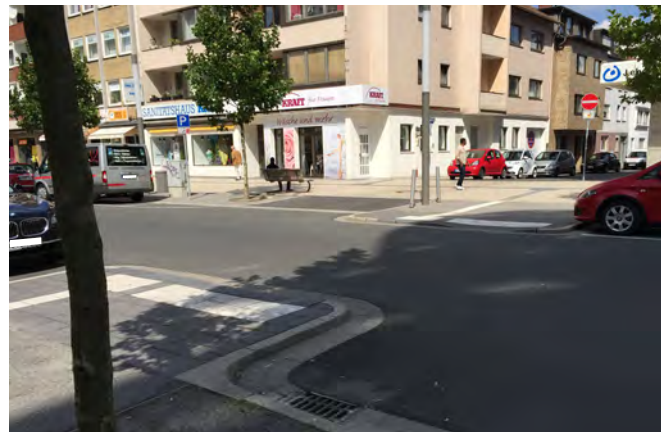
Referenz Fußgängerübergang (Dortmund)
