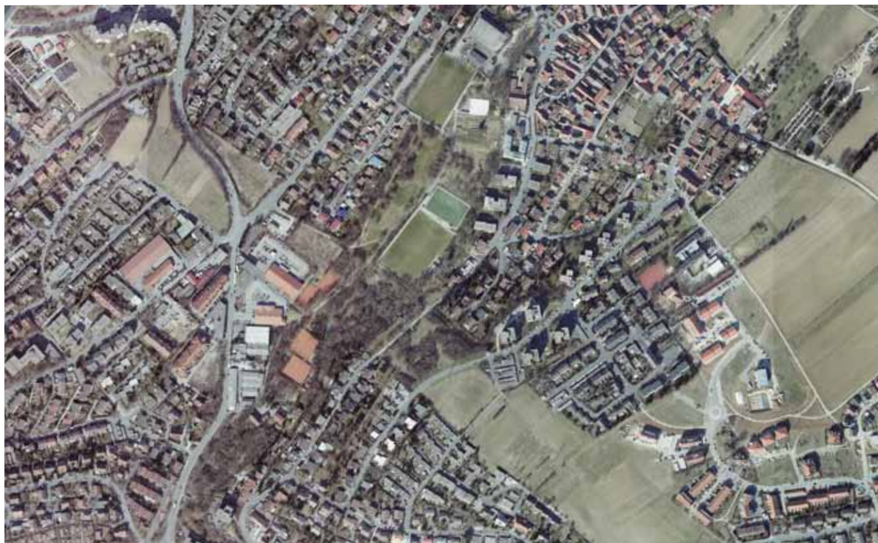
ABB 040 Grün- und Freiraumstruktur im Kürnachtal und der Hochspannungstrasse Quelle: FA Geodaten und Vermessung der Stadt Würzburg
