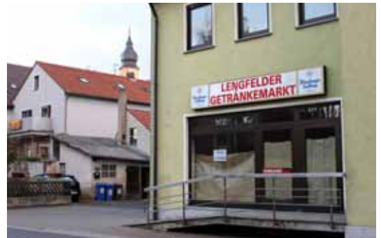
ABB 028 Leerstehende Ladenlokale im Altort
