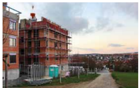
ABB 016 Neubau zwischen Altort und Pilziggrund Quelle: SSR
