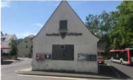
Altes Feuerlösch-Gerätehaus von Norden
