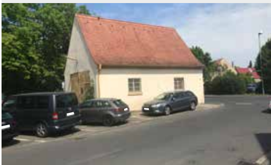
Altes Feuerlösch-Gerätehaus von Osten mit Parkplätzen
