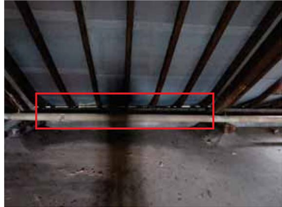
**Abb. 7:** Spalten im Dachtraufenbereich auf dem Dachboden
