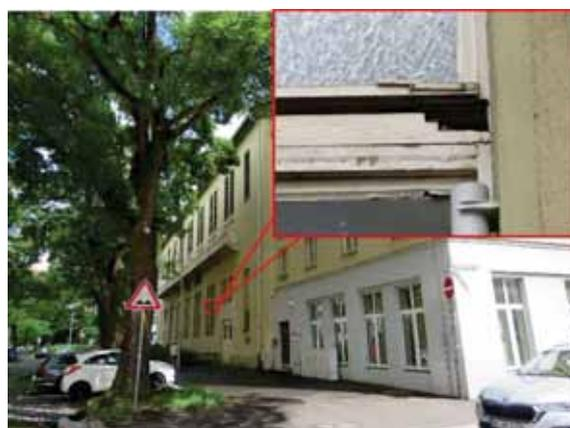
**Abb. 5:** Potenzielle Einflugmöglichkeit an Fensterrahmen
