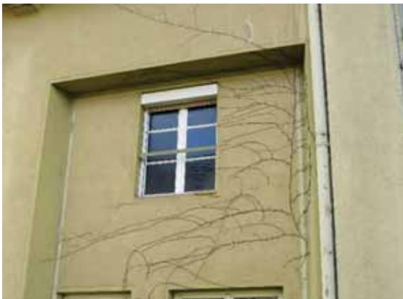
**Abb. 26:** Rollladenkasten auf der Hofseite des Gebäudes
