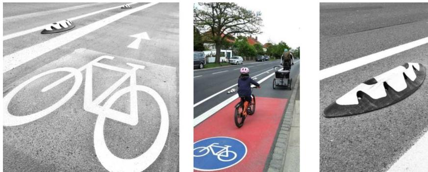
**Bild 25:** Baulicher Schutz von Radfahrstreifen mit sogenannten „Orcas“ [Quelle: Baureferat, Fachbereich Tiefbau und Verkehrswesen]
