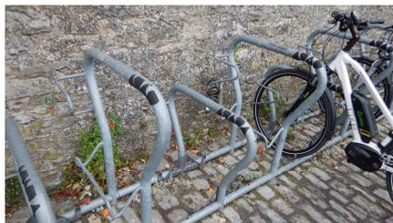
**Bild 3:** Fahrradbügel mit kombinierten Vorderradhaltern (hoch und tief) [Quelle: BSV]
