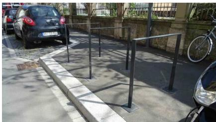
**Bild 2:** Flachstahlanlehnbügel
