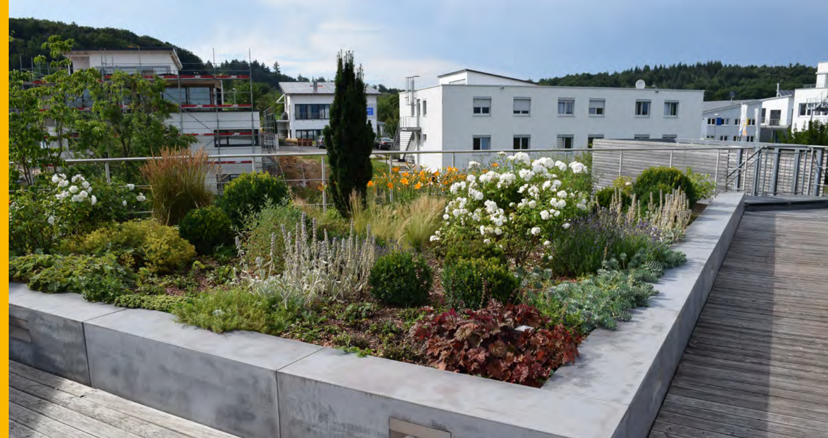
Dachbegrünung als sommerlicher Wärmeschutz für Innenräume © Nürtingen_Zinco
