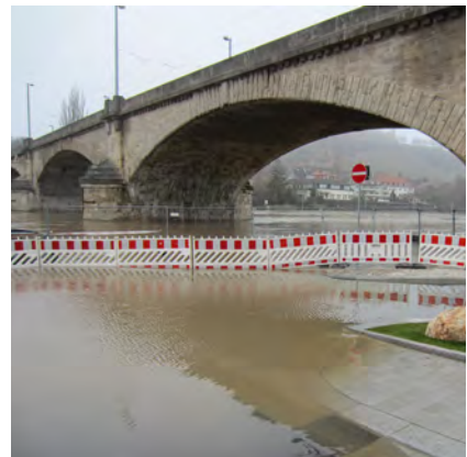
Überschwemmung in Würzburg ©.Stadt Würzburg
