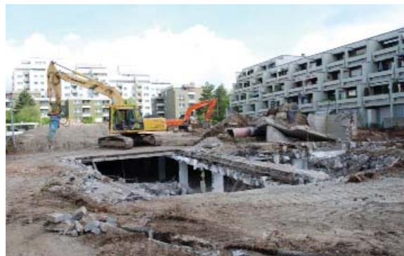
Abbruch des Tiefgaragenabschnitts
