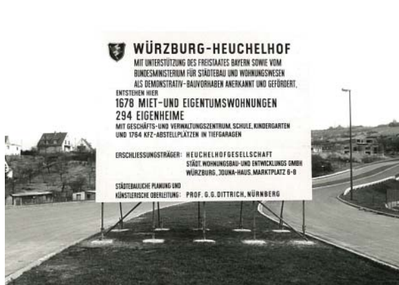
Bauschild über die Siedlungserweiterung Heuchelhof
