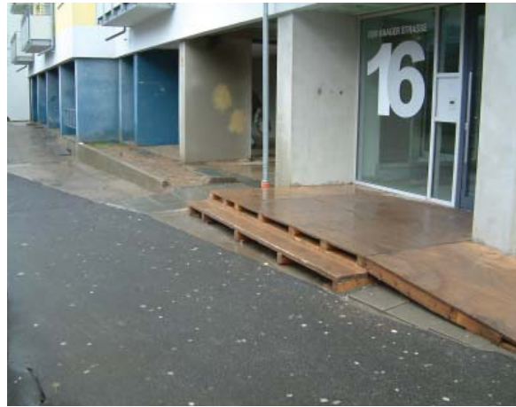
Arkaden Den Haager Straße 14-18 während des Umbaus
