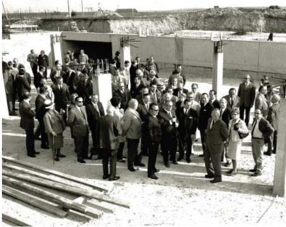
Der Würzburger Stadtrat besichtigt den Bau der Tiefgaragen
