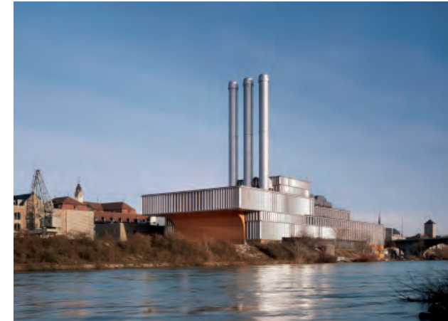
Modernisiertes Heizkraftwerk an der Friedensbrücke Quelle: WVV
