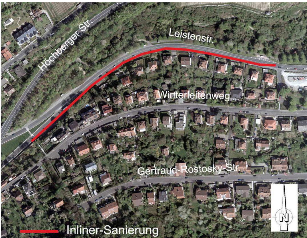
Inlinersanierung in der Leistenstraße
