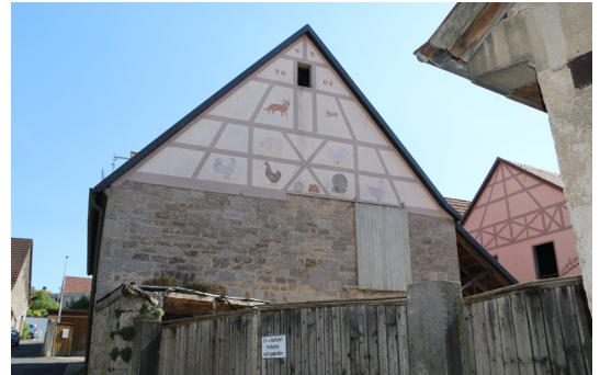
ABB 015 Histor. Wirtschaftsgebäude im Ortskern Quelle: SSR
