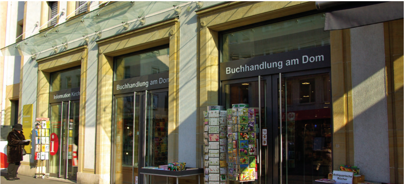
Gelungene Integration einer Werbeanlage als architektonisches Gliederungselement der Fassade
