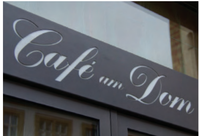
Ausgestanzte Buchstaben mit hinterlegtem Transparent
